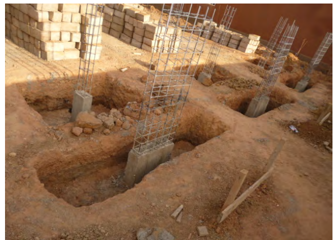
Die Fundamente für den Erweiterungsbau des Centre Persis sind gelegt
