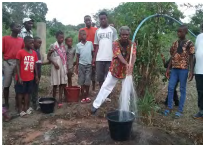
Das sprudelnde Bohrloch - 450m vom Gila Hospital entfernt
